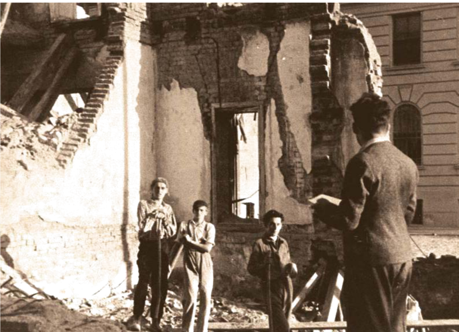
Wiederaufbauarbeiten nach dem 2. Weltkrieg
